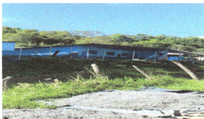
Foto1: SE OBSERVA EL CENTRO EDUCATIVO CON LOS TRABAJOS FINALIZADOS.
