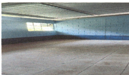
Foto 3: SE OBSERVA EL AMBIENTE DE UNOS DE LOS MODULOS CON EL PISO CERAMICO,
