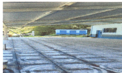
Foto 6: VISTA DONDE SE OBSERVA LOS BAÑOS REMODELADOS.
