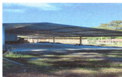
Foto 2: VISTA DEL CORREDOR DEL CENTRO EDUCATIVO YA FINALIZADO.
